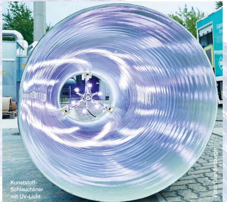
Kunststoff-Schlauchliner mit UV-Licht
