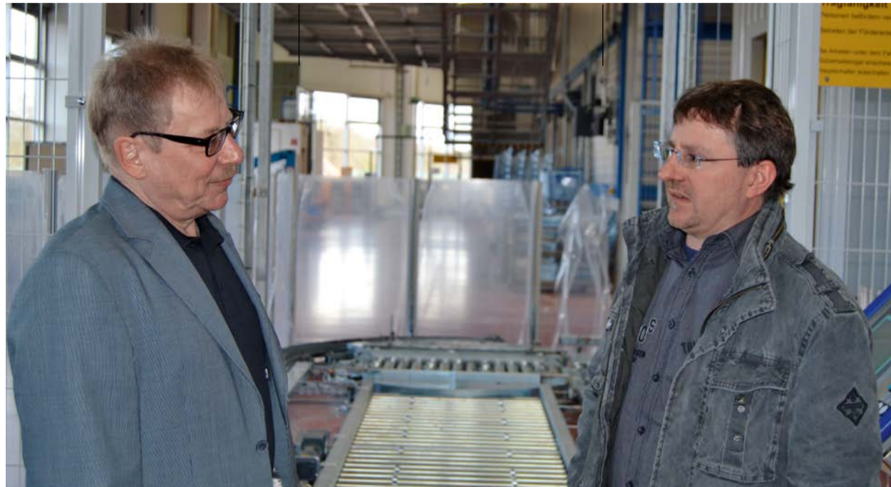
Reinhold Michl, Vertriebsaußendienst/Anwendungstechnik von Mulco-Mitglied Roth Ingenieurtechnik aus Nürnberg (links) und Norbert Zachmann, Projektleiter bei der Technikmanufaktur Augenstein kurz vor der Inbetriebnahme der Etagenheber bei Wanzl.
